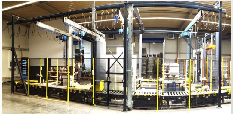
Freistehendes Portal mit Stahlbahn und vier Aluminiumbrücken; Be- und Entladestationen
